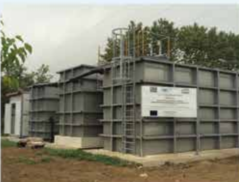
Compact μονάδα επεξεργασίας αστικών λυμάτων τεχνολογίας MBR της Κοιν. Στενημάχου Νάουσας Οργανική φόρτιση 60 kgBOD 5 /d (1.000 ισοδύναμα άτομα)
