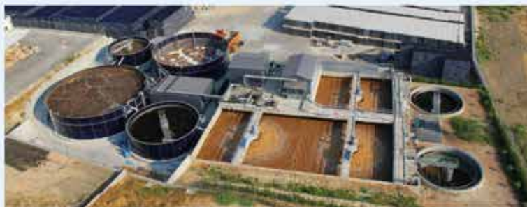
Μονάδα επεξεργασίας αποβλήτων Ολυμπιακής ζυθοποιίας (ΦΙΞ) Οργανική φόρτιση 2.700 kgBOD 5 /d (41.500 ισοδύναμα άτομα)
