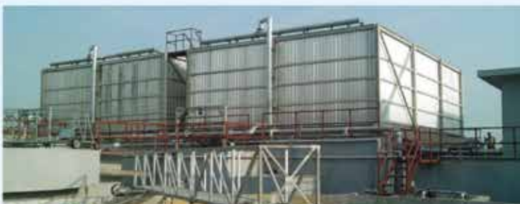
Μονάδα επεξεργασίας αποβλήτων Coca Cola Νιγηρίας με βιόπυργους Οργανική φόρτιση 900 kgBOD 5 /d (14.000 ισοδύναμα άτομα)
