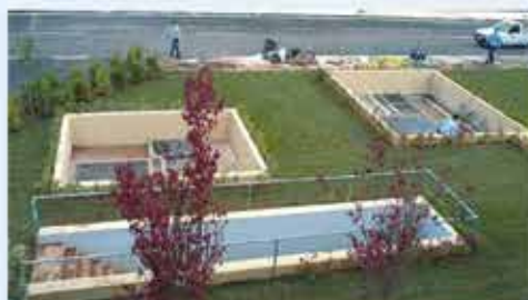
Υπεδάφια μονάδα MBR στο McArthur Glen, Σπάτα Οργ. φόρτ. 50 kgBOD 5 /d (800 ισοδύναμα άτομα)
