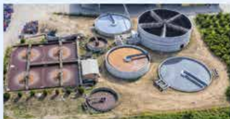
Μονάδα επεξεργασίας αποβλήτων χυμοποιίας ΑΣΠΙΣ Οργ. φόρτ. 10.000 kgBOD 5 /d (153.800 ισοδύναμα άτομα)
