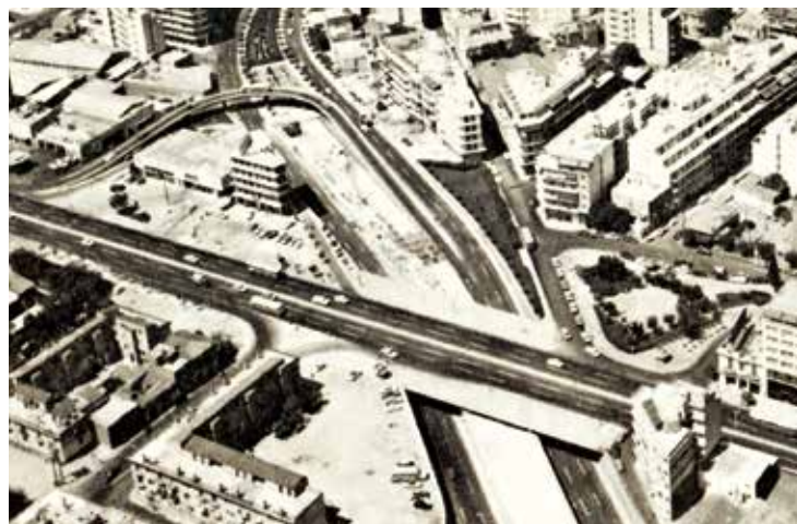
↑ Αερολήψη του Ανισόπεδου Κόμβου της Λεωφόρου Ιλίσσους (Αρχείο Υπουργείου Προεδρίας της Κυβερνήσεως)
