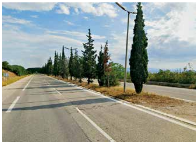
Η Εθνική Οδός 1 (Τμήμα: Καραθεόδωροι - Εύζωνοι) το οποίο είναι δύο κλάδων κυκλοφορίας με στερεά εγκιβωτισμού στην ενδιάμεση ζώνη/κυπάριο και χωρίς στηθαία (Πρόγραμμα Οδεύσεως)
