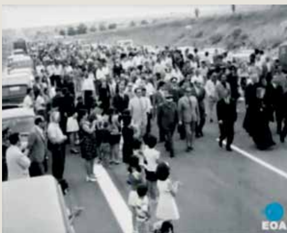
Τα εγκαίνια του τμήματος Βαθύλακκου - Ευζώνων της Εθνικής Οδού 1 τα οποία τελέστηκαν στον Βαθύλακκο το Σάββατο 28 Ιουλίου 1973 (Εθνικό Οπτικοακουστικό Αρχείο)
