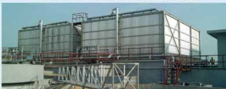
Μονάδα επεξεργασίας αποβλήτων Coca Cola Νιγηρίας με βιόπυργους
