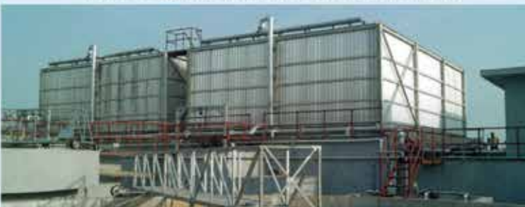
Μονάδα επεξεργασίας αποβλήτων Coca Cola Νιγηρίας με βιόπυργους
