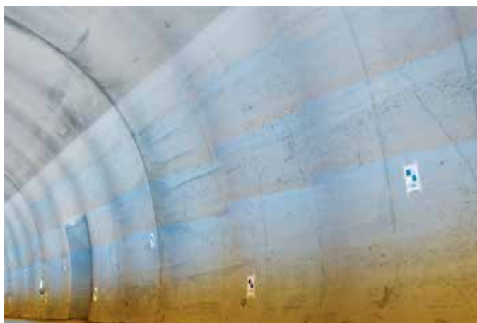
Φωτο 2: Δημιουργία Τρισδιάστατου Νέφους Σημείων Γεωμετρικής Απεικόνισης τούνελ Παναγοπούλας
