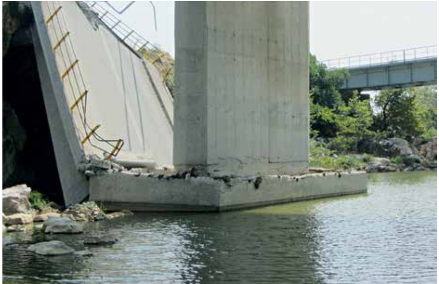
Στροφή θεμελίωσης
