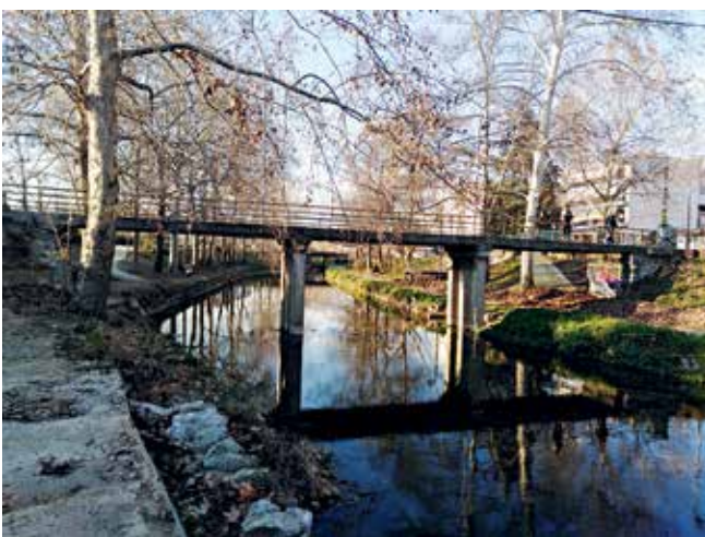
Πεζογέφυρα σε αστικό περιβάλλον
