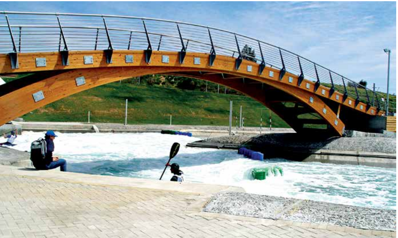
Φωτο 7. Ξύλινη γέφυρα στο Slalom
