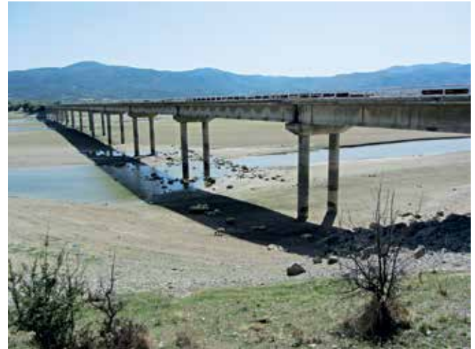
Γέφυρα πολλών ανοιγμάτων σε λίμνη φράγματος
