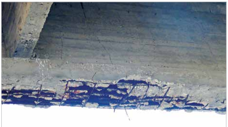
Αστοχία αποχετευτικού συστήματος - Διάβρωση οπλισμών - Αστοχίες τενόντων προέντασης
