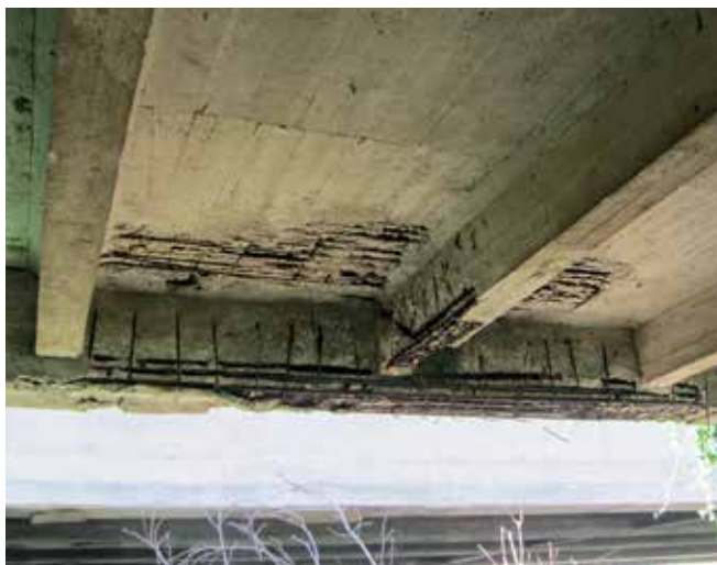
Βλάβες λόγω αστοχίας απορροής
