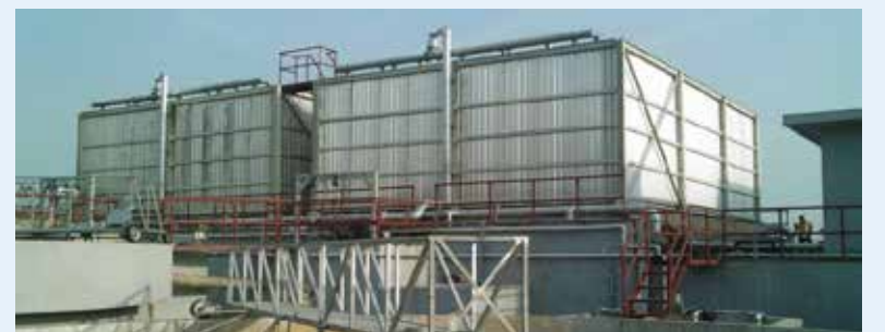
Μονάδα επεξεργασίας αποβλήτων Coca Cola Νιγηρίας με βιόπυργους Οργανική φόρτιση 900 kgBOD 5 /d (14.000 ισοδύναμα άτομα)
