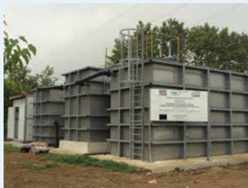
Compact μονάδα επεξεργασίας αστικών λυμάτων τεχνολογίας MBR της Κοιν. Στενιμάχου Νάουσας Οργανική φόρτιση 60 kgBOD 5 /d (1.000 ισοδύναμα άτομα)
