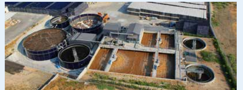
Μονάδα επεξεργασίας αποβλήτων Ολυμπιακής ζυθοποιίας (ΦΙΞ) Οργανική φόρτιση 2.700 kgBOD 5 /d (41.500 ισοδύναμα άτομα)
