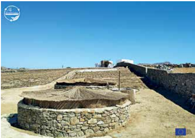
Υπεδάφιο σύστημα συλλογής και χρήσης βρόχινου νερού στη Μύκονο
